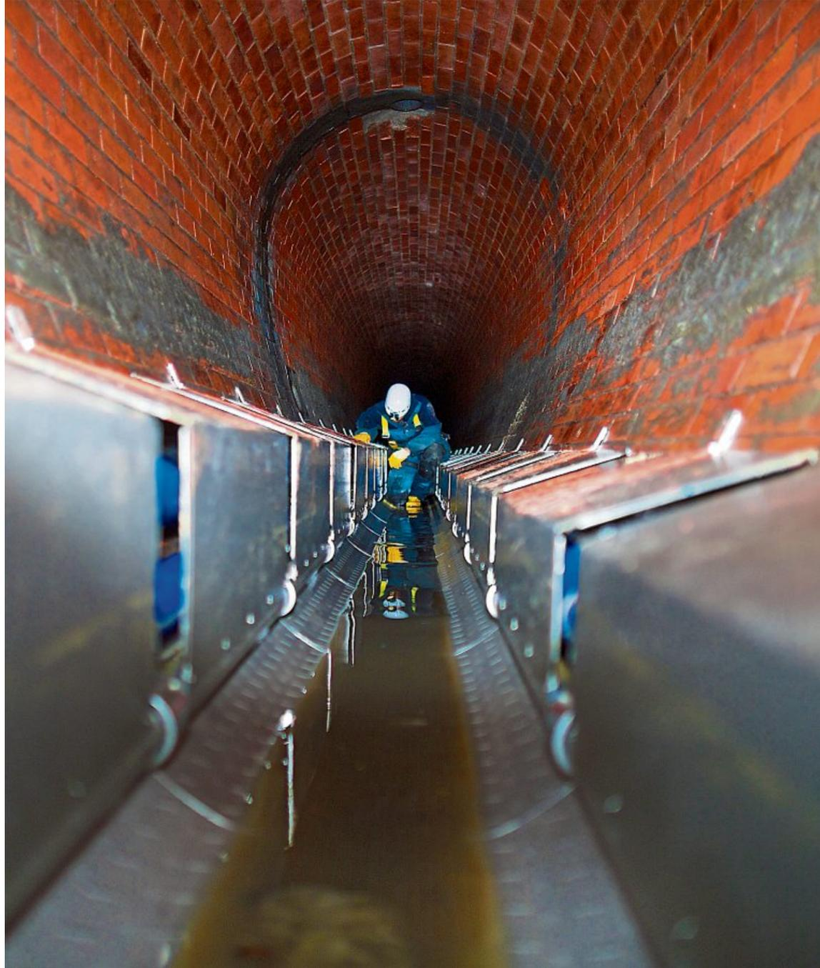
Energiegewinnung: Wärmetauscher in der Sohle eines Abwasserkanals.
