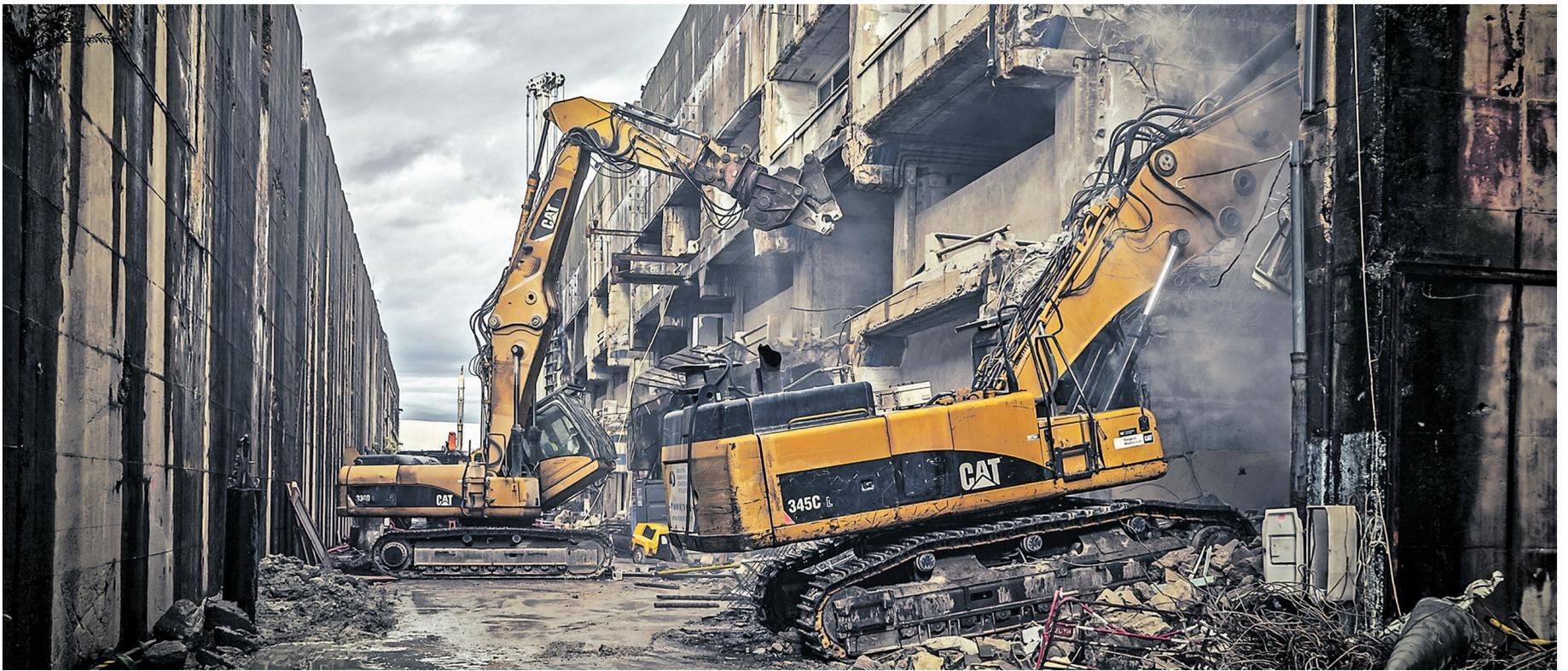
Schweres Gerät: Für die Verwandlung vom U-Boot-Hangar zum Datentresor wurden Teile des Gebäudes mithilfe von Baggern abgetragen. Keine leichte Sache – die Außenmauern sind bis zu sechs Meter dick.
