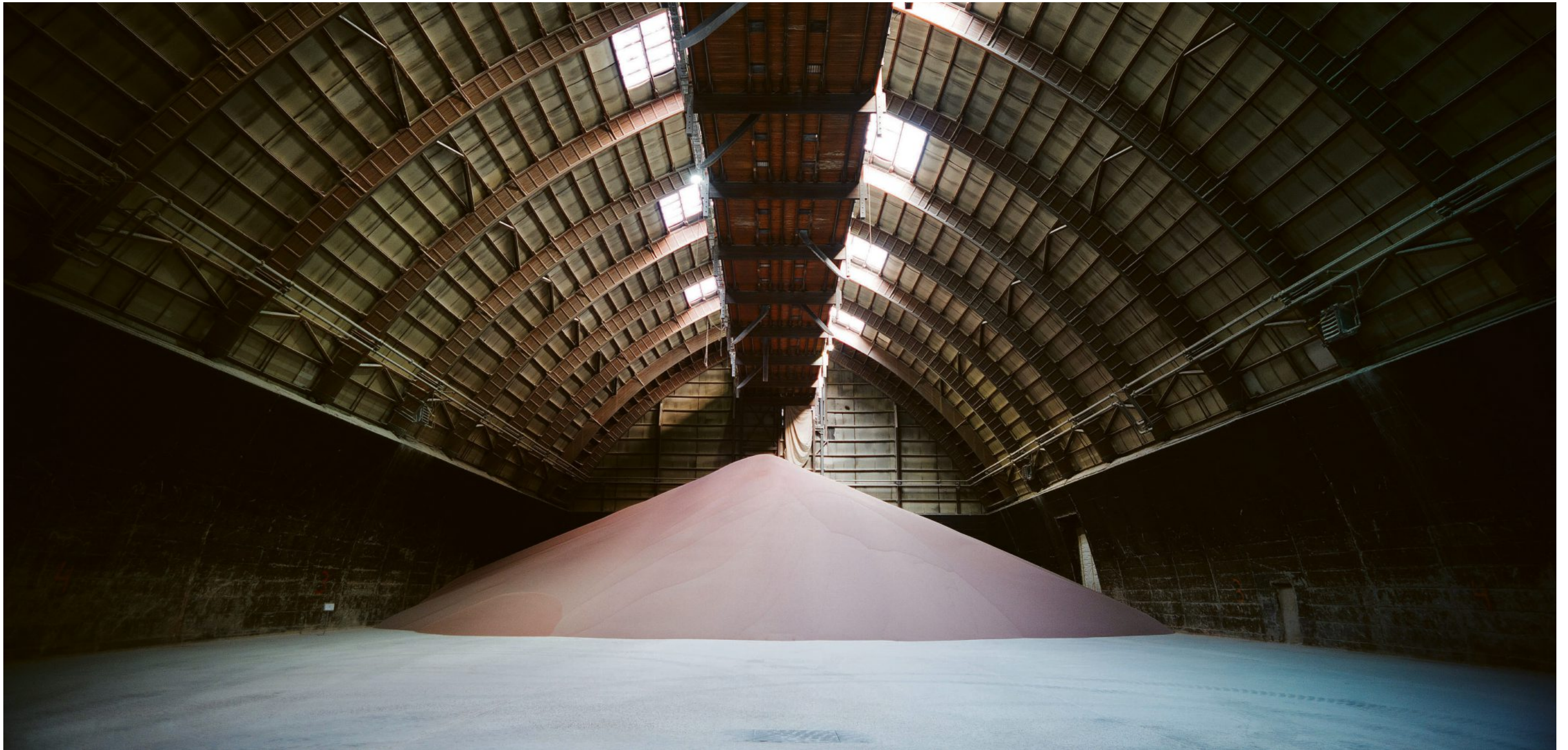
Körnchen des Wachstums: In Hallen, die so groß sind wie Kathedralen, lagert auf dem Fabrikgelände der Eurochem in Antwerpen ein Berg Stickstoffdünger, dessen Früchte eine Stadt ernähren könnten.
